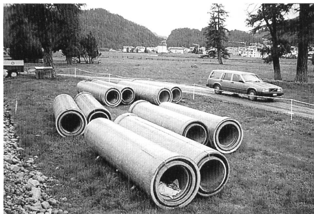
Bild 2. Doppelrohrleitungen «SECA» liegen auf der Baustelle zum Einbau bereit.
