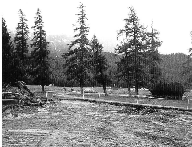
Bild 1. Im Landschaftsschutzgebiet im Oberengadin werden Tiefbauarbeiten für die Kanalisation vorbereitet.
