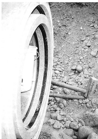
Bild 3. Detailaufnahme der Steckverbindung des «SECA»-Doppelrohrsystems.
