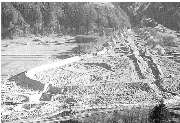
Bild 4. Ein Geschiebesammler, dessen Dämme 2000 m lang sind, umfasst jetzt das Mündungsgebiet des Wildbaches und bietet für die Umgebung einen Schutz (Foto datiert 13.11.1946).
