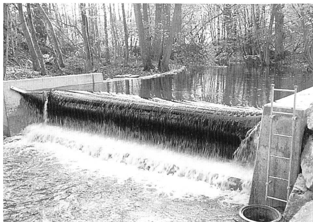
Bild 1. Luftgefülltes Schlauchwehr.
