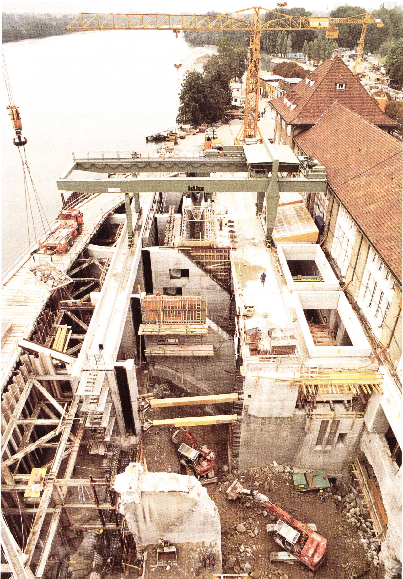
Bild 16. Im Bereich der Turbinenschächte wurden die alten Baustrukturen vollständig ersetzt.
