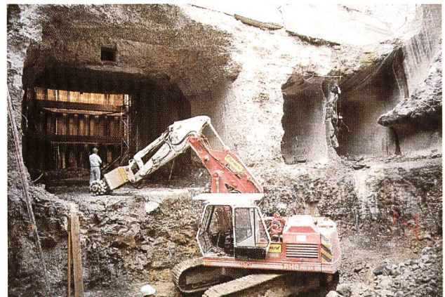
Bild 14. Bei den Abbrucharbeiten unterhalb der Kote der alten Saugrohre konnten weitere geologische Erkenntnisse gewonnen werden.
