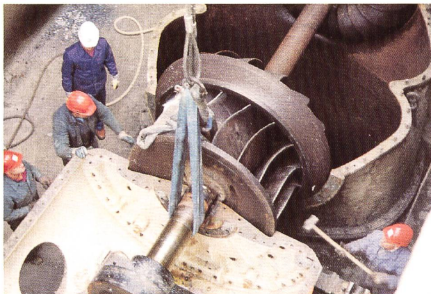
Bild 26. Vorgängig der Abbrucharbeiten mussten die alten Turbinen demontiert und der Verschrottung zugeführt werden.
