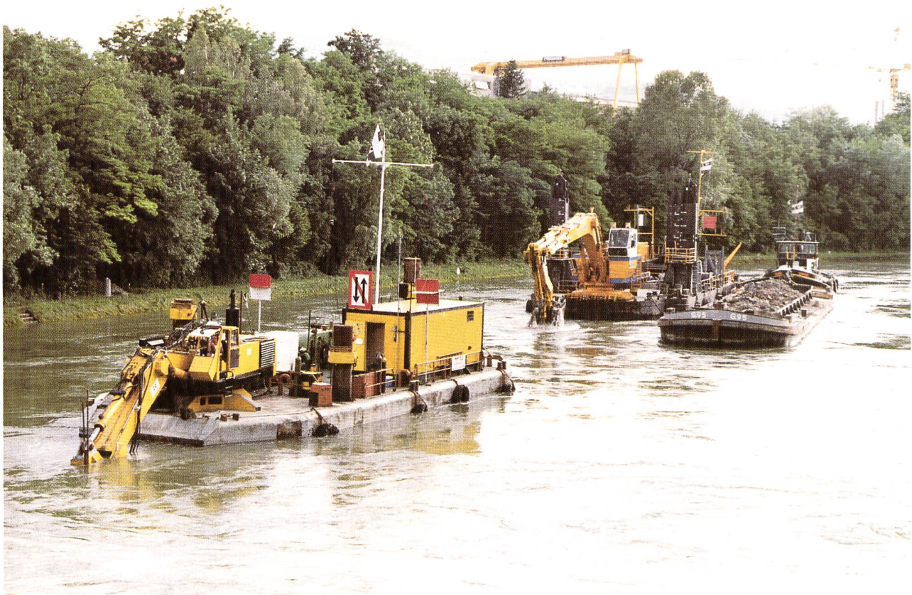
Bild 55. Für die Unterwasseraustiefung wurden Aushub- und Meisseleinheiten auf Stelzenpontons eingesetzt.
