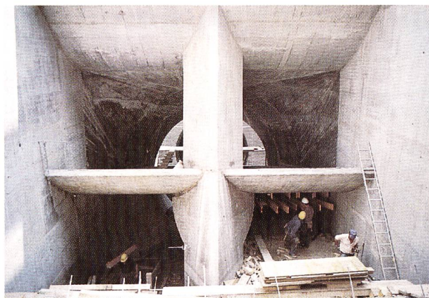
Bild 30. Im senkrechten Pfeiler des Einlaufbauwerkes ist die Lage der Straflo-Turbine integriert.
