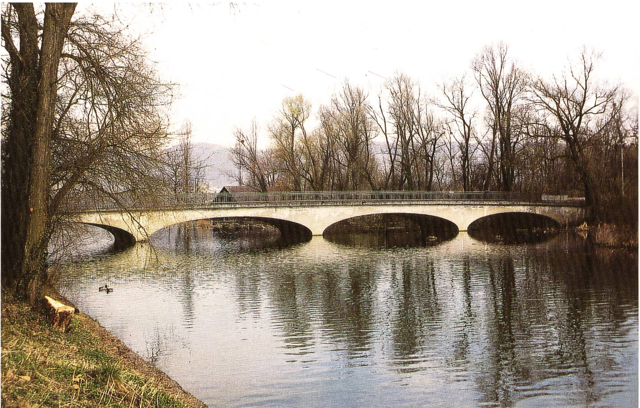
Bild 57. Die Brücke bei der Ergolzmündung.
