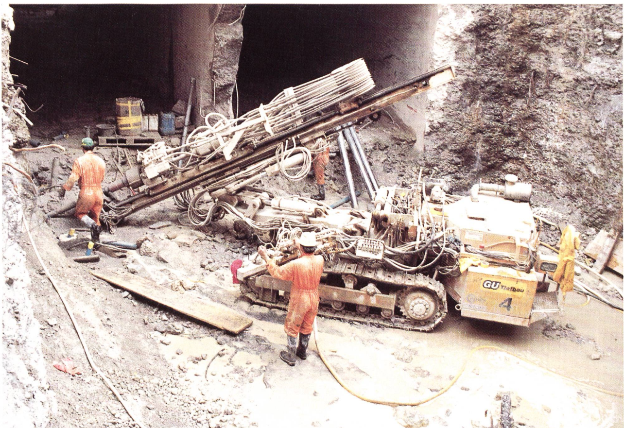
Bild 23. Ein Bohrgerät im Einsatz.
