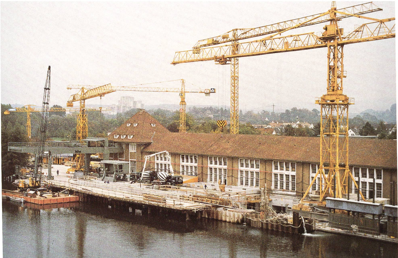
Bild 22. Grosse Baukrane prägten lange Zeit das Bild der Baustelle.
