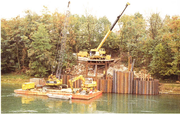
Bild 54. Die Uferausweitungsarbeiten im Unterwasserkanal erlauben auch Schiffen bis 110 m Länge ein sicheres Ein- und Ausfahren aus der Schleuse.
