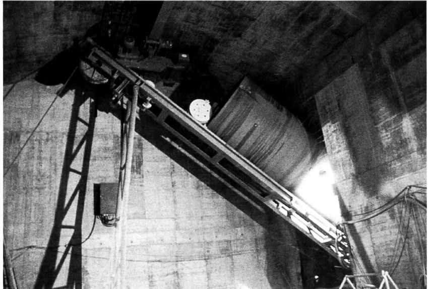
Bild 2. Profilanpassung bei der Durchfahrung der Triasformation durch Marciavantiverfahren.
