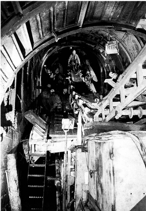
Bild 3. Übergangszone zwischen horizontalem und schrägem Abschnitt des Druckschachtes. Einbau der Vortriebsmaschine am Fuss des 80 % geneigten Druckschachtes.
