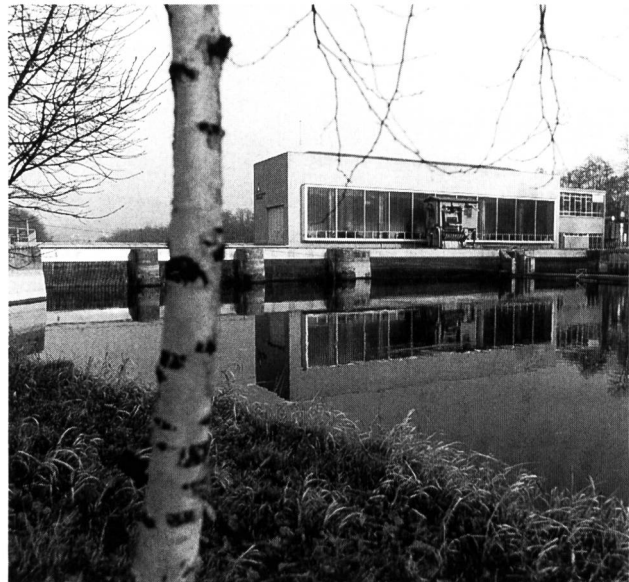
Bild 3. Das Kraftwerk Rüchlig-Aarau mit Krafthaus und Rechenreinigungsanlage.
