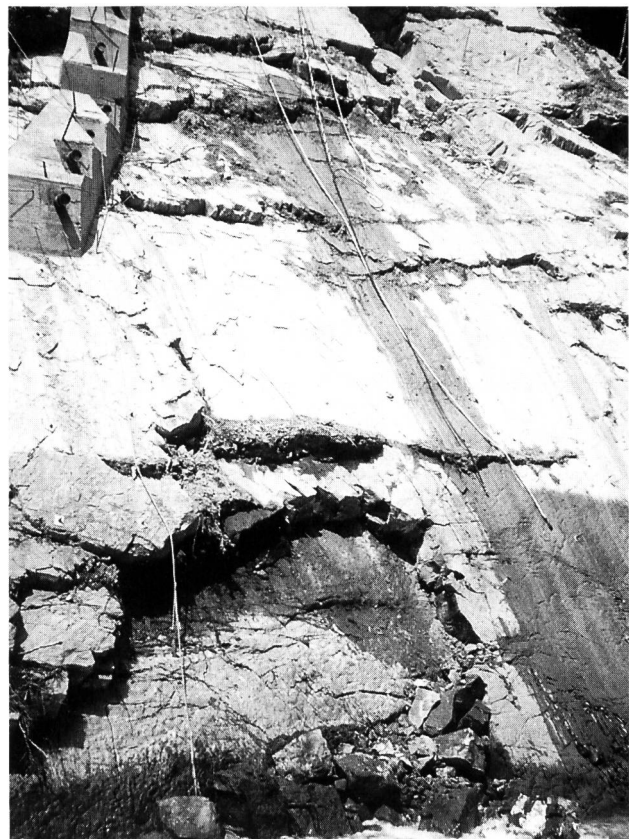
Bild 7. Geschieberückhaltesperre Palanggenbach. Das linke Widerlager – mit einem verankerten Betonriegel und Felsnägeln gesichert – während den Betonarbeiten.
