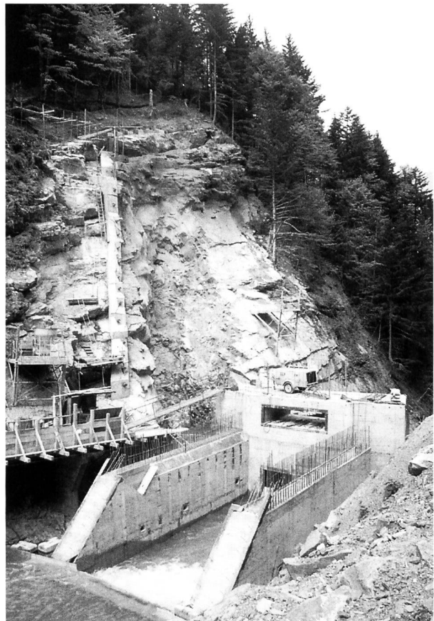
Bild 6. Geschieberückhaltesperre Palanggenbach. Das linke Widerlager wurde mit einem verankerten Betonriegel und Felsnägeln gesichert. Baustelle vor dem Aushub.
