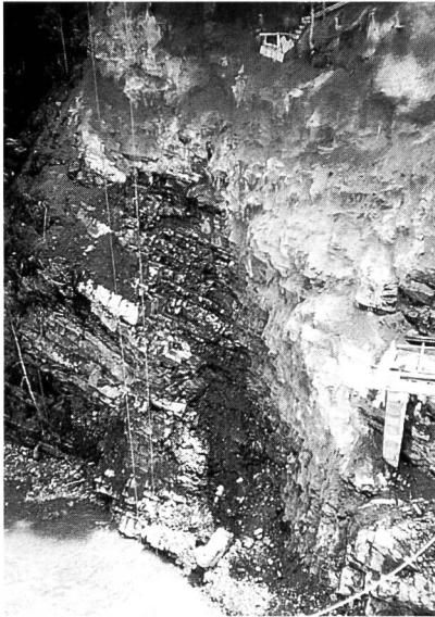
Bild 3. Geschieberückhaltesperre Palanggenbach. Aushub rechtes Widerlager mit Stabilisierungsmassnahmen über der künftigen Kronenkote.
