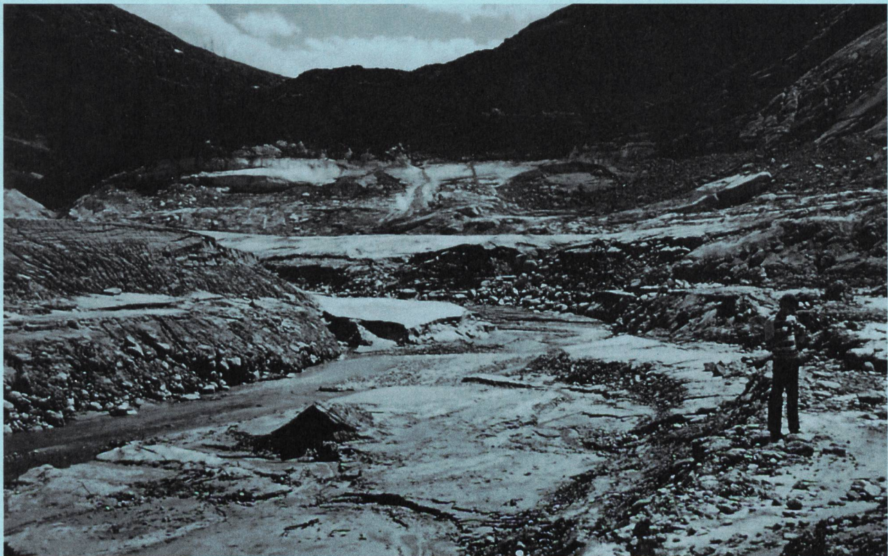
Verlandung im Stausee Rättrichsboden; die Aare hat sich in die Ablagerungen eingefressen.
