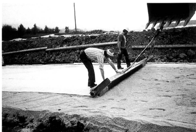
Bild 1. Verlegung der Dichtungsmatte Bentofix D 4000 direkt auf der Gasdränage aus Glassand.
