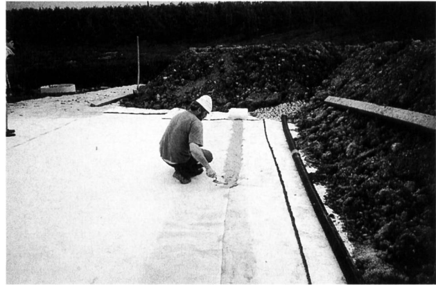
Bild 2. Kantenabspachtelung der Dichtungsmatte Bentofix D 4000.
