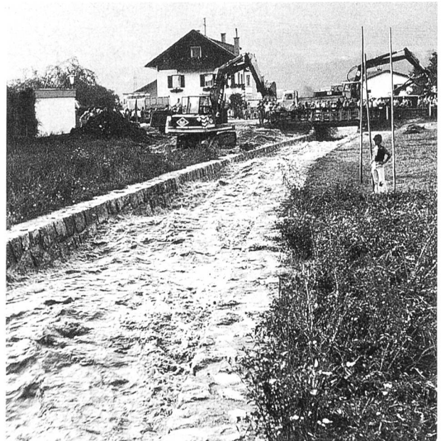
Bild 2. Volderbach bei Hochwasser nach Dämpfung der Wellen mittels Stangen und Baggern (Bild: H. Lang).
