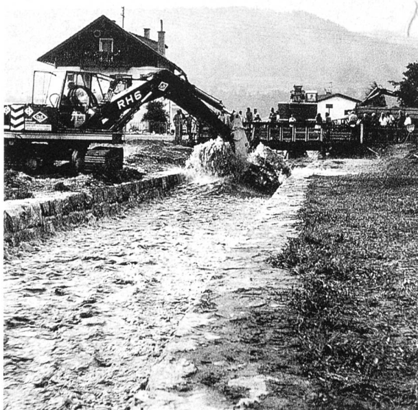
Bild 1. Volderbach bei Hochwasser mit stehenden Wellen, die das Freibord verringern (Bild: H. Lang).
