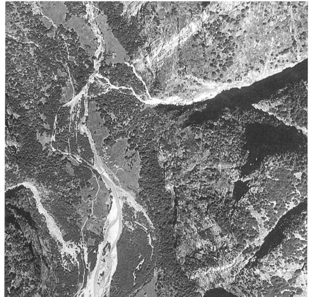
Bild 4b, oben. Ablagerungen des Murgangs vom 31. August 1992 auf dem Kegel des Ri di Foioi. Das alte Gerinne verlief auf der rechten Kegelseite. Der teilweise übermurate Weiler Faèd befindet sich auf der linken Kegelseite, neben der Brücke über die Bavona. (Foto: F. Spinedi, Locarno-Monti, 12. September 1992)
