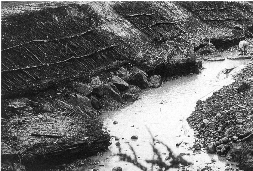
Bild 3, links. Ingenieurbilogische Bautechniken werden im Erd- und Wasserbau zur Lösung von Erosions- und Instabilitätsproblemen verwendet. (Worble BE, Mai 94/ Bild: VAW, M. Oplatka).
