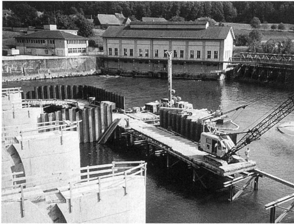
Bild 11. Arbeiten am Fangedamm.
