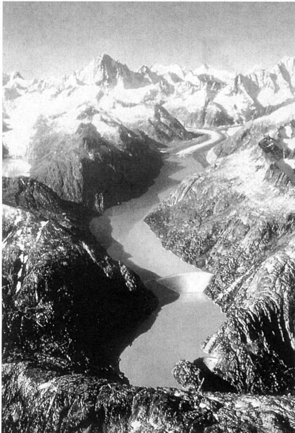
Bild 1. Fotomontage: Der heutige Grimselsee mit der Spitalampersperre im Vordergrund; die zusätzliche Talsperre gemäss Projekt 1988 mit dem dahinter höhergestauten Grimselsee.
