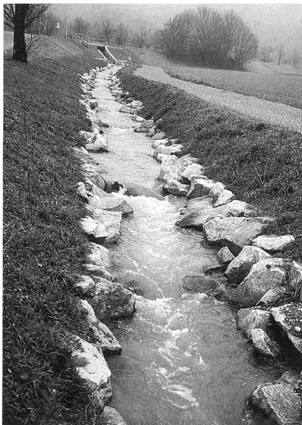
Bild 4. Der Fischpass Aarberg konnte teilweise als Bach gestaltet werden. Die Uferbepflanzung braucht noch etwas Zeit.
