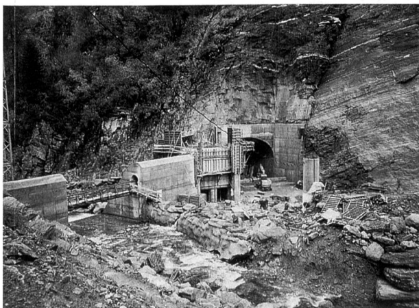
Der Einlauf zum Umleitstollen der Rovana, Bauzustand vom 11. Oktober 1996.
