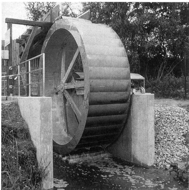
Turas-Wasserrad mit 4,80 m Durchmesser im Ablauf des Klärwerks Warendorf.
