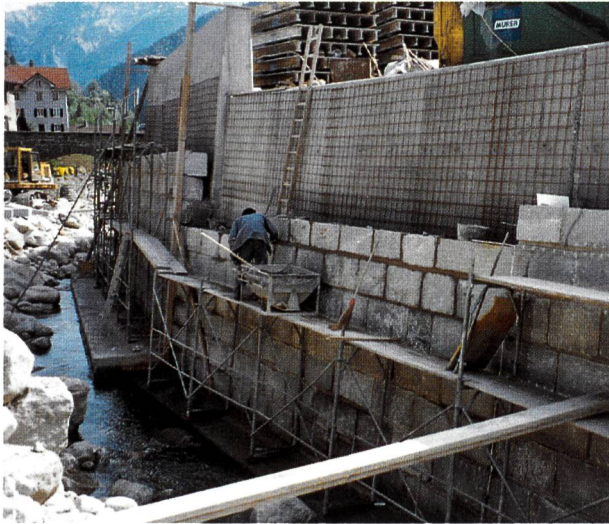
Bild 9. Vormauerung der Betonmauer vor der Kirche in Richtung Wilerbrücke gesehen.
