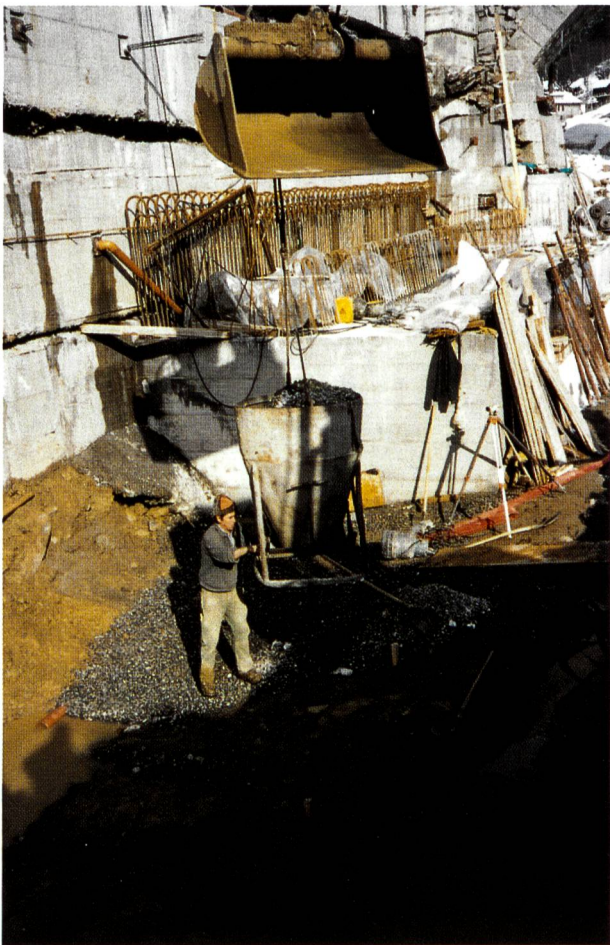
Bild 5. Entwässerung Fundamentbereich mit Sickerleitung, Sickerkies und Entwässerungsgraben.
