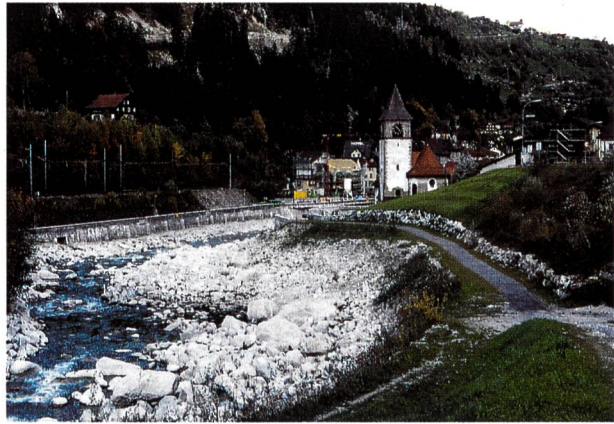
Bild 5. Hauptschutzelement B: Verdeckte Schutzmauer und Blockwurf oberhalb der Kirche.
