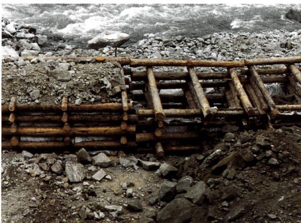
Bild 10. Krainerwand im Bau.
