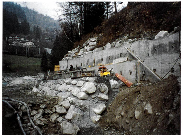
Bild 11. Gewicht-/Winkelstützmauer nördlich des Steintals.
