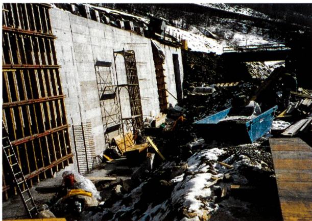
Bild 8. Betonmauer Bauteil 19 Kirche Süd.
