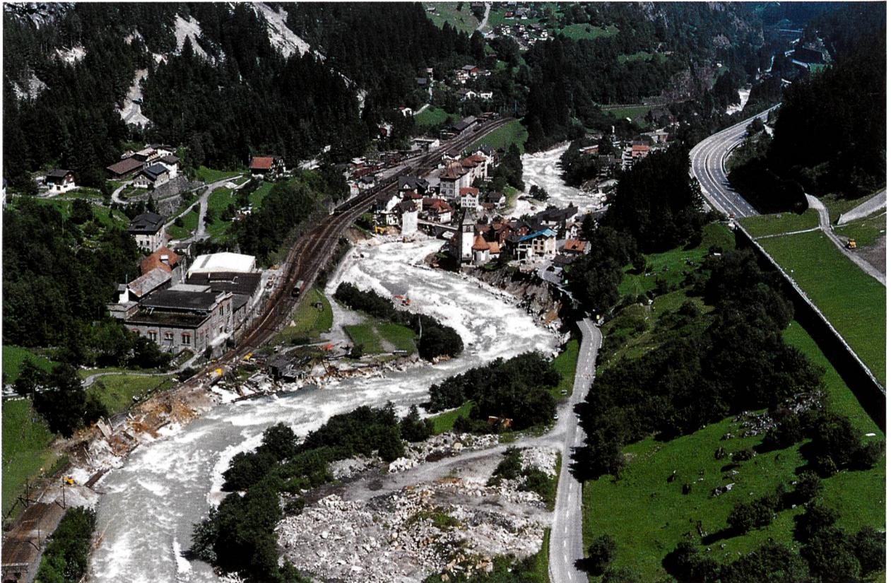
Bild 4. Hauptschäden südlich der Wilerbrücke.
