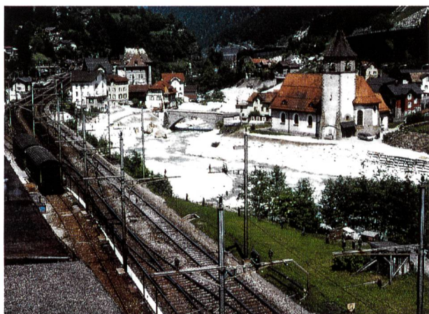
Bild 3. Gurtellen mit der Gotthardbahn.
