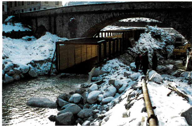
Bild 6. Hauptschutzelement C. Umleitkanal bei der Dorfbrücke.
