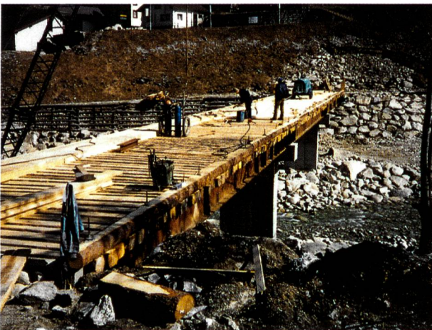
Bild 2. Erstellung der Baubrücke südlich Kirche.
