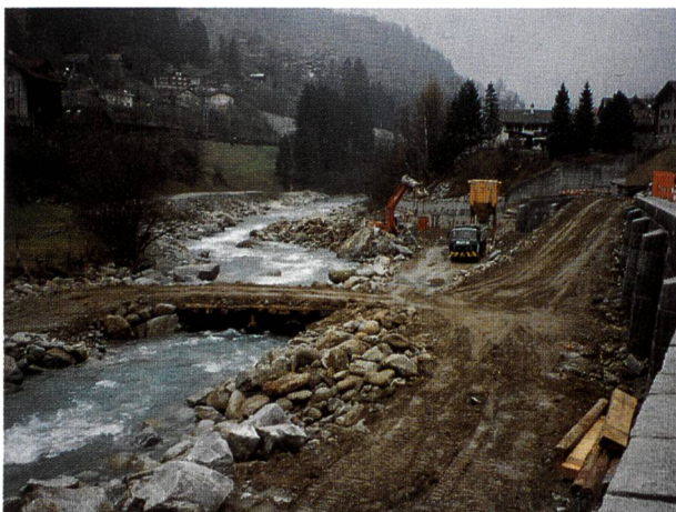
Bild 10. Bau-Furt nördlich der Wilerbrücke.
