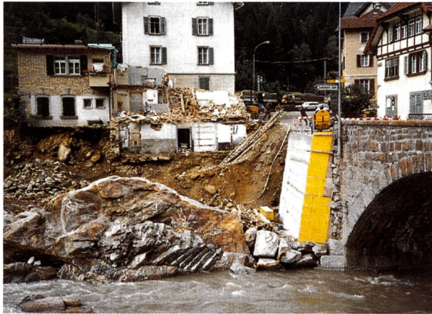
Bild 8. Unterfangung linkes Widerlager Wilerbrücke.
