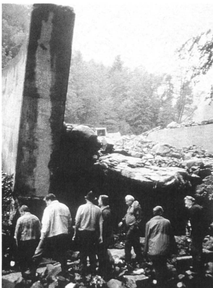
Bild 2. Das Unwetter in Giswil OW vom 9. Juni 1996. Infolge Unterspülung durch das Steinibach-Hochwasser wurde der Flügel einer massiven Betonsperre freigelegt.
