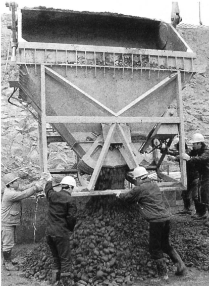
Bild 8. Betoneinbau für die Staumauer.
