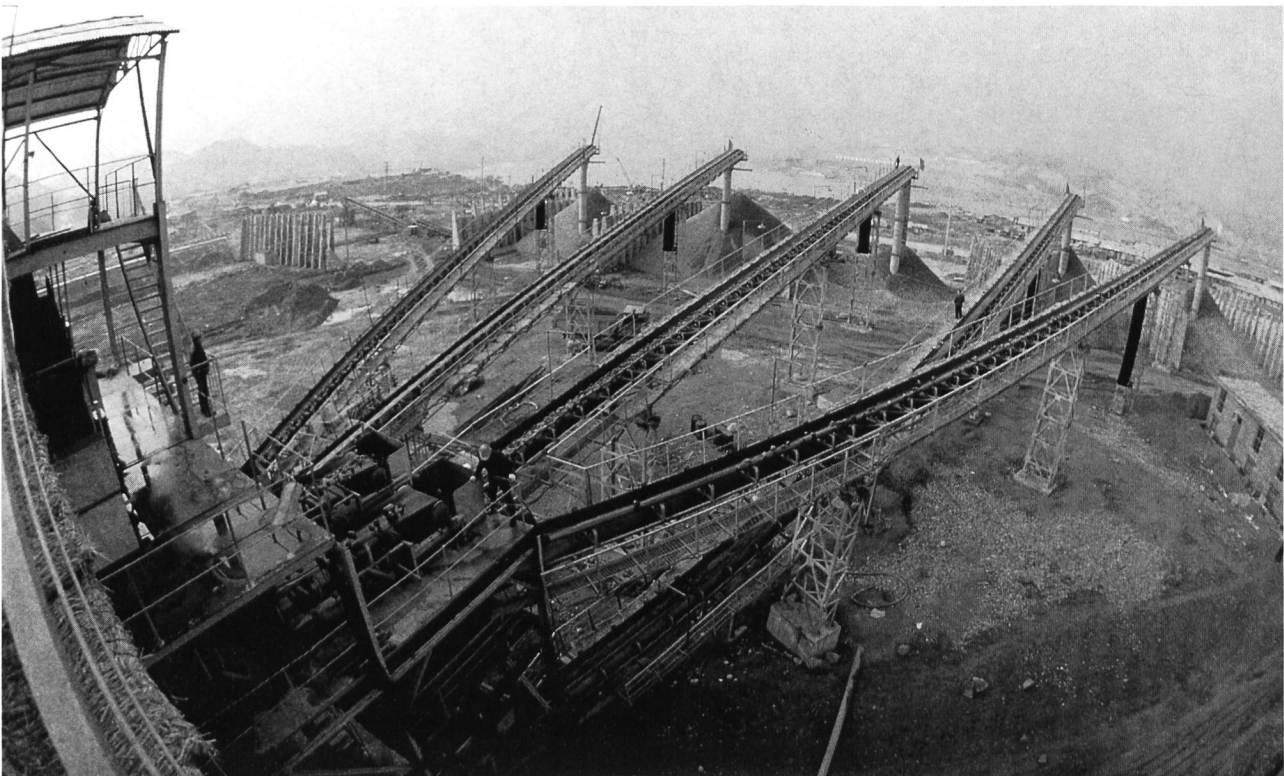
Bild 9. Zuschlagstofflager für die Betonbereitung.
