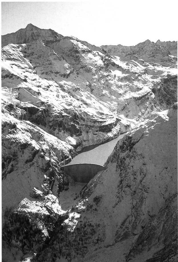
Bild 1. Die 1989 bis 1991 um 15,5 m erhöhte Bogenstaumauer Mauvoisin (Wallis) ist 250 m hoch. Der Stausee fasst 211 Mio m 3 Wasser, das in den beiden Stufen Fionnay und Riddes genutzt wird.
