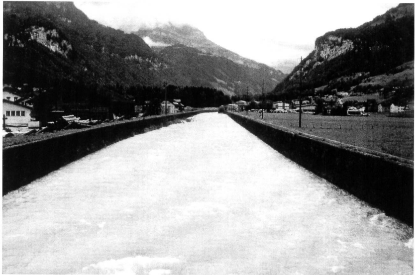
Bild 5. Engelberger Aa, Abschnitt 4: stark verbauter und kanalisierter Unterlauf bei Büren. Fotos: Christine Bratrich.
