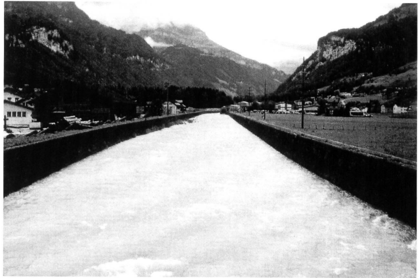
Bild 5. Engelberger Aa, Abschnitt 4: stark verbauter und kanalisierter Unterlauf bei Büren. Fotos: Christine Bratrich.
