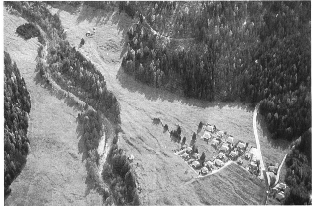
Fig. 3. Anciennes traces de lave torrentielle sur un torrent du Val Ferret (Valais).
