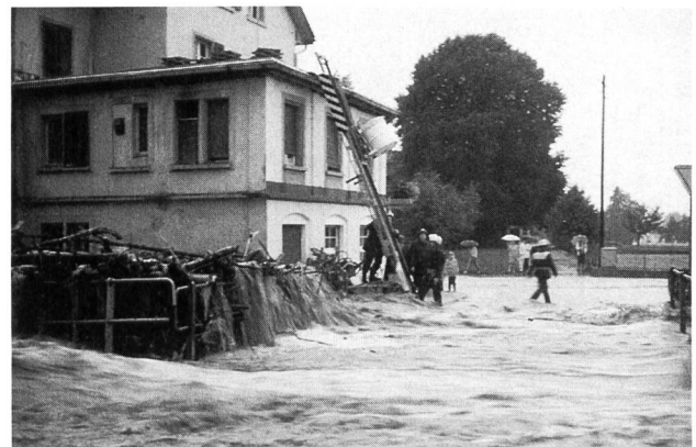
Bild 2. Hochwasser August 1984: Brücke Eichholzstrasse beim Restaurant Talhof.
