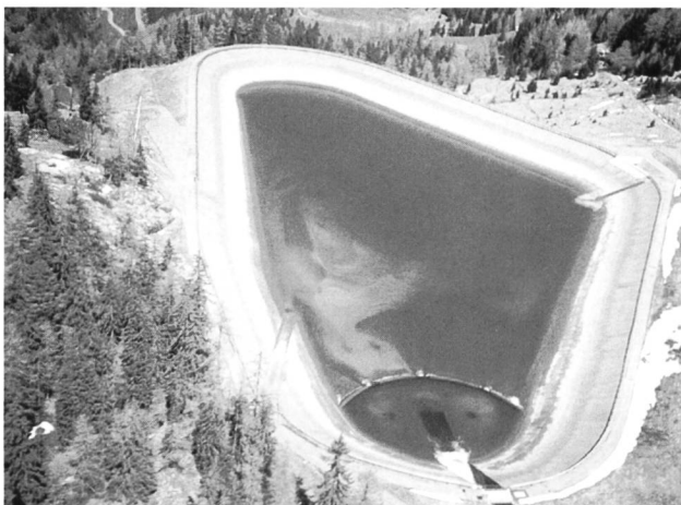
Figure 2. Vue aérienne du bassin des Esserts.
