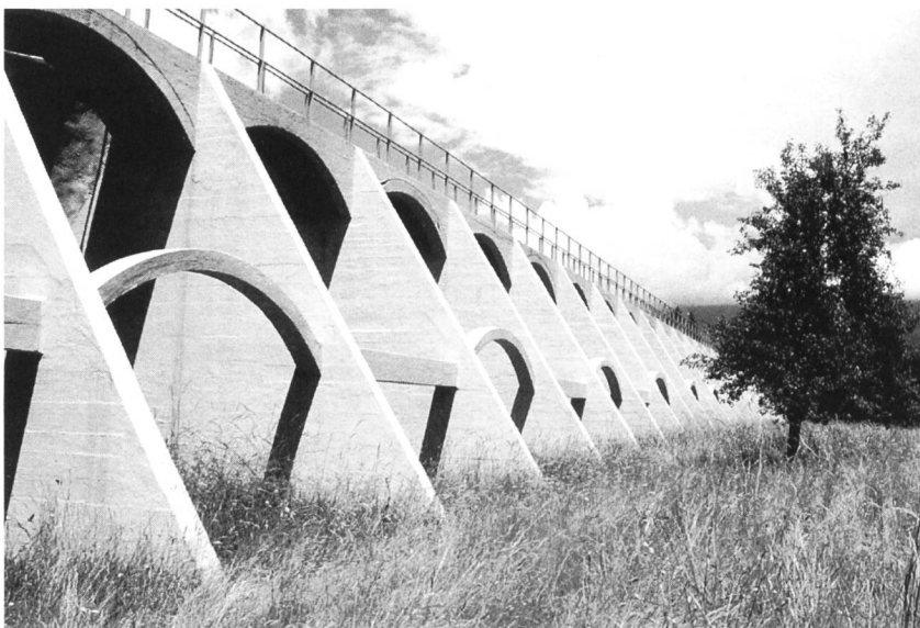
Figure 1. Vue du barrage des Marécottes depuis l'aval.
