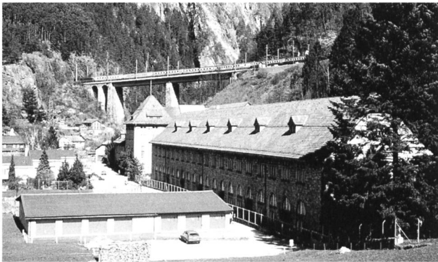
Usine d'Amsteg (UR): pilier nord de l'alimentation en énergie de la ligne du Gothard depuis 1922, elle va voir sa puissance presque tripler dès l'an prochain.
