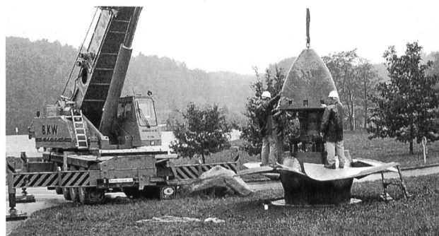
Bild 1. Generalrevision beim Wasserkraftwerk Bannwil 1997–2000. Das ausgediente Kaplan-Turbinenrad wiegt 22 t; sein Durchmesser beträgt 4200 mm.
