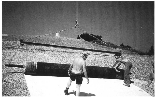
Bild 2. Ausrollen der Dichtungsmatte.
