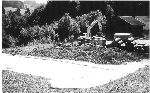
Bild 3. Schüttung der Rekultivierungsschicht.
