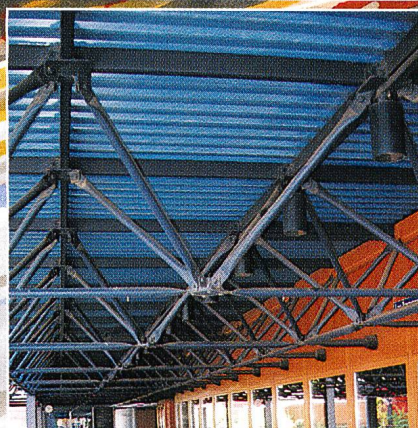
Fachwerkkonstruktion EPFL in Ecublens
