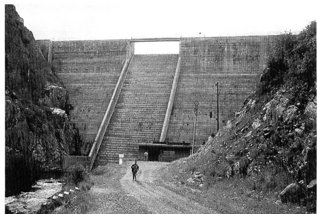
Bild 5. Ansicht des Stagecoach Dam in Colorado mit konventionellem Beton auf der Luftseite und Krafthaus am Mauerfuss.
