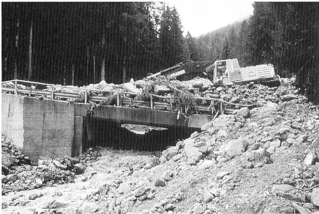
Bild 3. Landschaft Davos GR, 15. August 1998. Geschiebestau des Chummerbaches beim Brückendurchlass Hitzenbodenstrasse, etwa Kote 1560 (Foto: C. Hegg, WSL).
