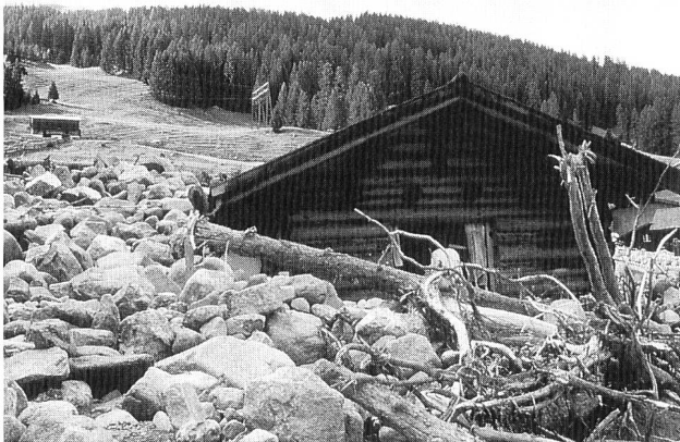
Bild 4. Davos-Glaris GR, 15. August 1998. Ein durch die Geschiebeausbrüche des Chummerbaches beschädigtes Gebäude im Kegelbereich. Insgesamt lagerte der Bach rund 50 000 m 3 Material ab (Foto: C. Hegg, WSL).
