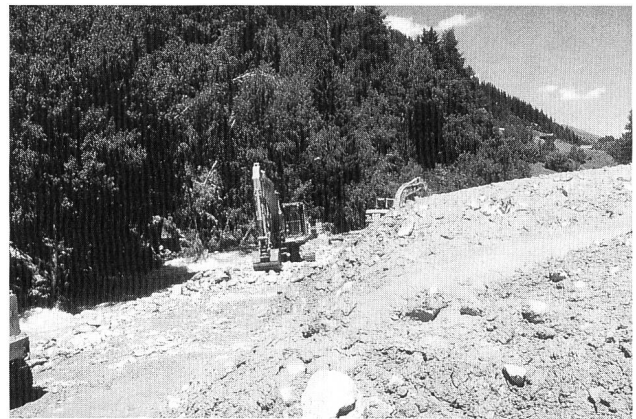
Bild 2. Steinhaus-Niederwald VS, 5. Juli 1998. Stau der Rotte/Rhone infolge von Murgängen des Rufibaches. Das Bild zeigt die sofort eingeleiteten Baggerarbeiten, um eine Verkläusung zu verhindern (Foto: C. Hegg, WSL).
