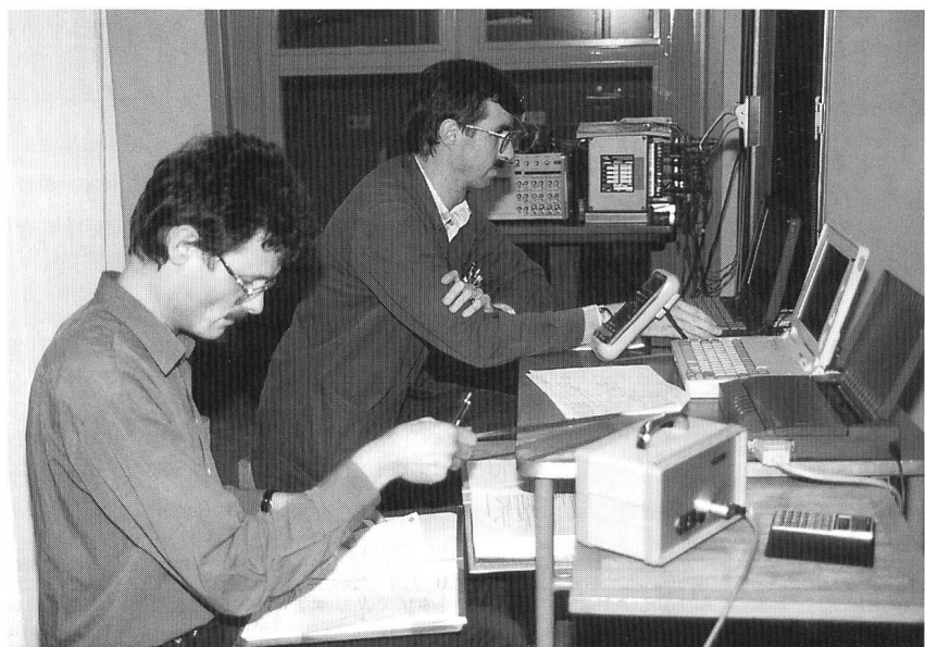
Bild 2. Die modernen Schutz- und Leitsysteme werden bei der Inbetriebsetzung mit tragbaren Rechnern kontrolliert und eingestellt. Die Laptops sind nicht mehr wegzudenken.
