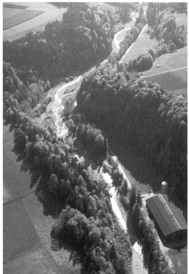
Figure 16. Le Schwarzwasser en aval de Rüscheegg-Graben. Le cours d'eau n'occupe plus que la moitié de la vallée. Le rehaussement du lit va mettre en danger les zones agricoles et artisanales, ainsi que la route (Photo J.Cl. Bersier, Fribourg).
