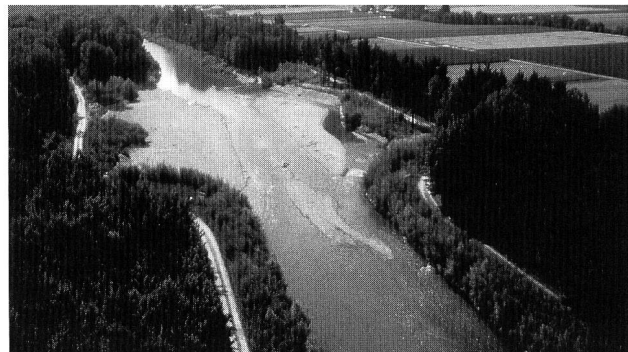
Bild 5. Kiesablagerungen in der «Birne».
