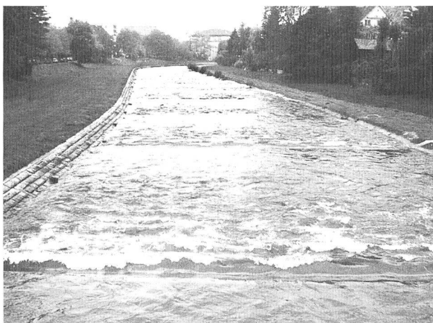
Bild 5. Für Forellen in der Birs im Raum Basel gibt es aufgrund des Regelfprofils nur wenige Sohlen- und Uferstrukturen und damit Deckung. Umfangreiche Kiesumlagerungen bei Winterhochwässern zerstören bereits angelegte Laichgruben oder verdriften die frisch geschlüpften Fische.
