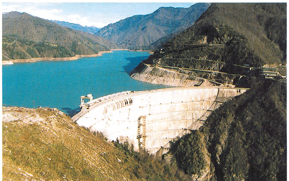
Bild 1. Übersicht über die Staumauer Enguri.
