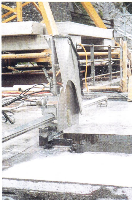
Bild 5, links. Luftseitige Ansicht der Abbrucharbeiten im linken Wehrfeld. Die Wehrbrücke im Feld I wurde bereits entfernt und der Wehrpfeiler I/III bis zur Mitte gekürzt. Zur Gewährleistung der Wehrpassage wurde eine Hilfsbrücke erstellt. Dabei diente die ausgebaute Grundablassschütze als Brückenplatte. Bild 6, rechts. Einsatz einer schienengeführten Betonfräse beim Abbruch der Wehrbrücke.
