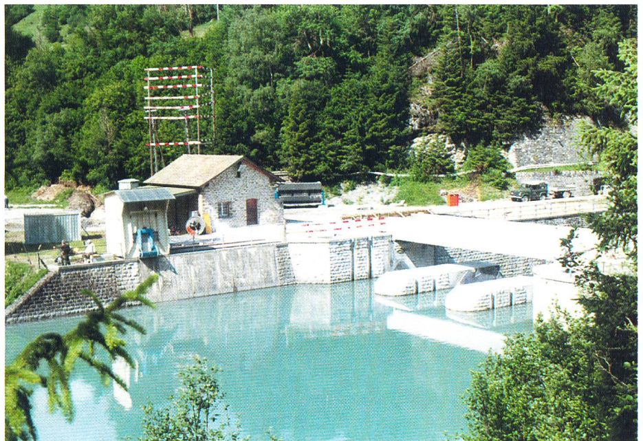
Bild 10. Wasserseitige Ansicht des umgebauten Wehres und des linken Widerlagers mit Rechenreiniger und Betriebsgebäude.
