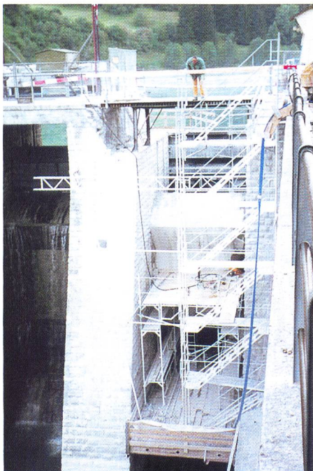
Bild 5, links. Luftseitige Ansicht der Abbrucharbeiten im linken Wehrfeld. Die Wehrbrücke im Feld I wurde bereits entfernt und der Wehrpfeiler I/III bis zur Mitte gekürzt. Zur Gewährleistung der Wehrpassage wurde eine Hilfsbrücke erstellt. Dabei diente die ausgebaute Grundablassschütze als Brückenplatte. Bild 6, rechts. Einsatz einer schienengeführten Betonfräse beim Abbruch der Wehrbrücke.
