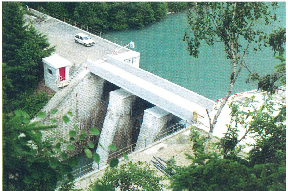
Bild 11. Übersicht aus der Vogelperspektive auf die umgebauete Wehranlage. Auf dem rechten Widerlager ist talseitig der Zugang zu den Antriebsorganen sichtbar.
