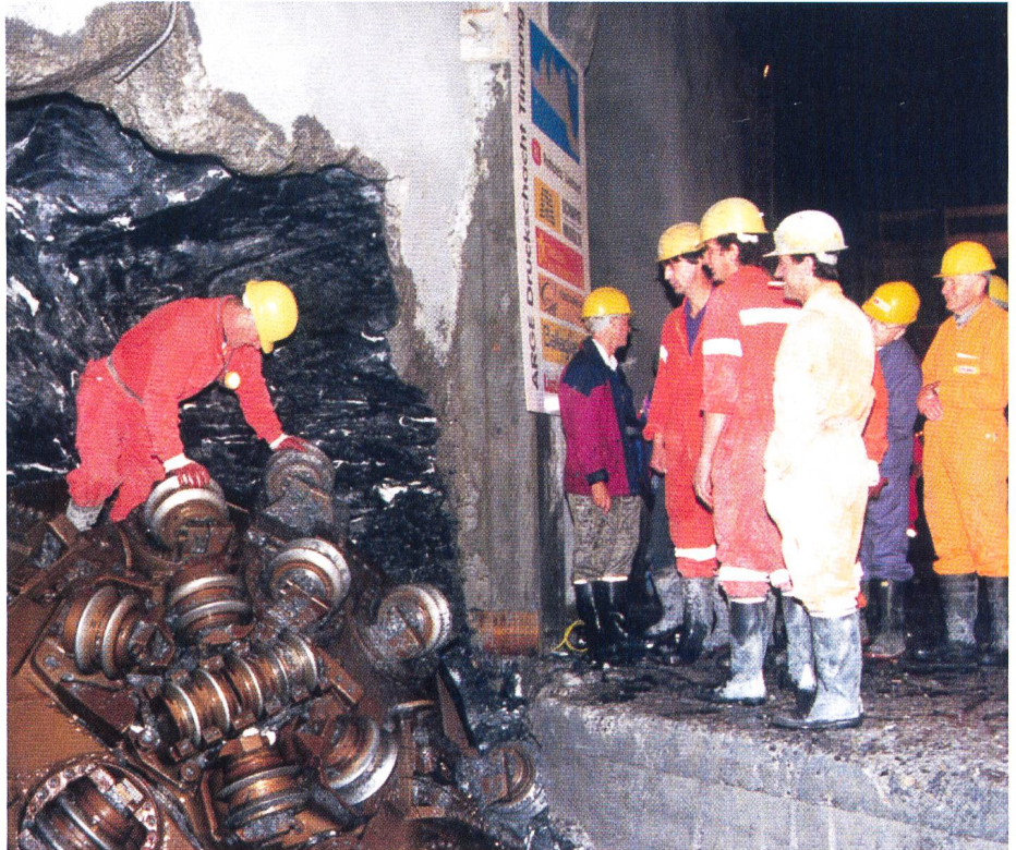
Bild 9. Durchschlag des Schrägschachtes in die Drosselklappenkaverne am 10. September 1997.
