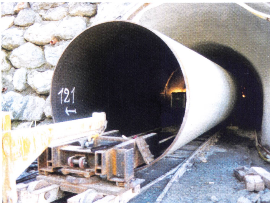
Bild 11. Transport der 12 m langen Rohre für den Rohrstollen. Der Aussenkorrosionsschutz wurde schon im Werk aufgebracht.
