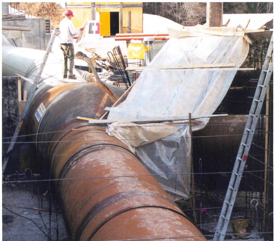
Bild 6. Anschlussbereich bei Zentrale. Im Vordergrund neuer Teil Verteilung mit Schalungen für Fixpunkt. Im Hintergrund Übergang Rohrkeller in den Rohrstillen.
