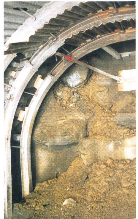
Bild 2. Marciavanti-Vortrieb im Rohrstollen durch die Sackungsmasse.
