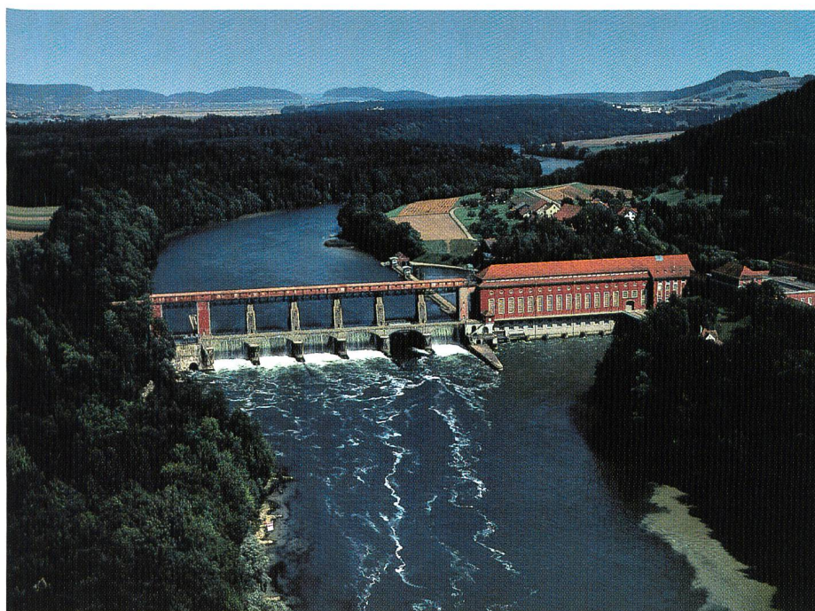
Bild 1.1. Ansicht der Anlage.
