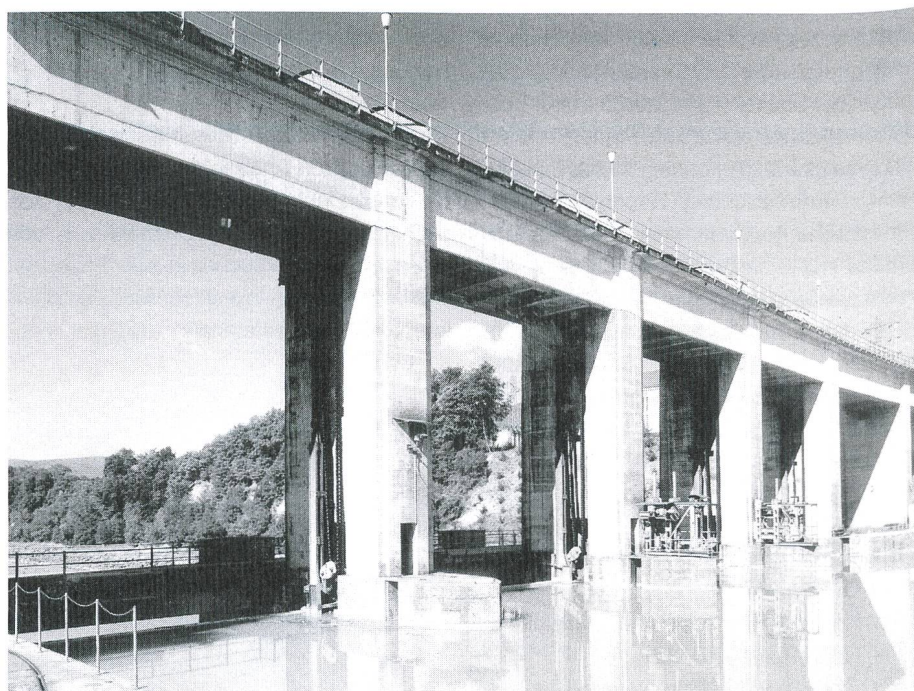
Figure 2. Vue de l'ensemble des piliers du barrage depuis l'amont.
