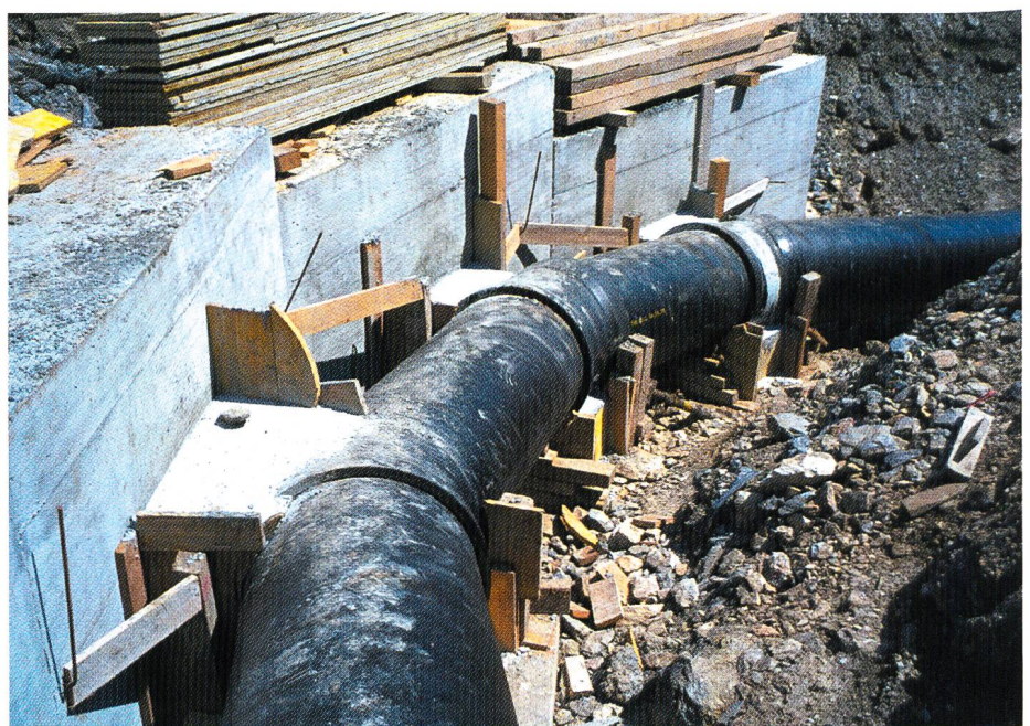
Bild 4. Das massive Betonwiderlager nimmt am Knickpunkt die riesige Auslennkraft der Druckleitung auf. Nach dem Auffüllen ist von allem nichts mehr zu sehen.
