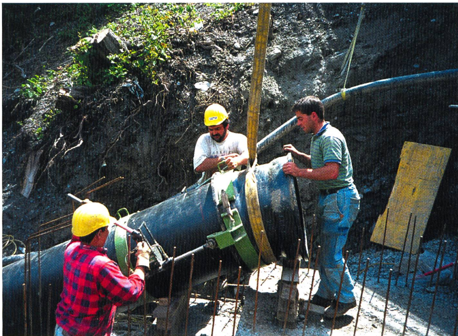
Bild 5. Das einfache Steckmuffensystem erlaubte die Montage der gusseisernen Druckleitung direkt durch den Bauunternehmer.
