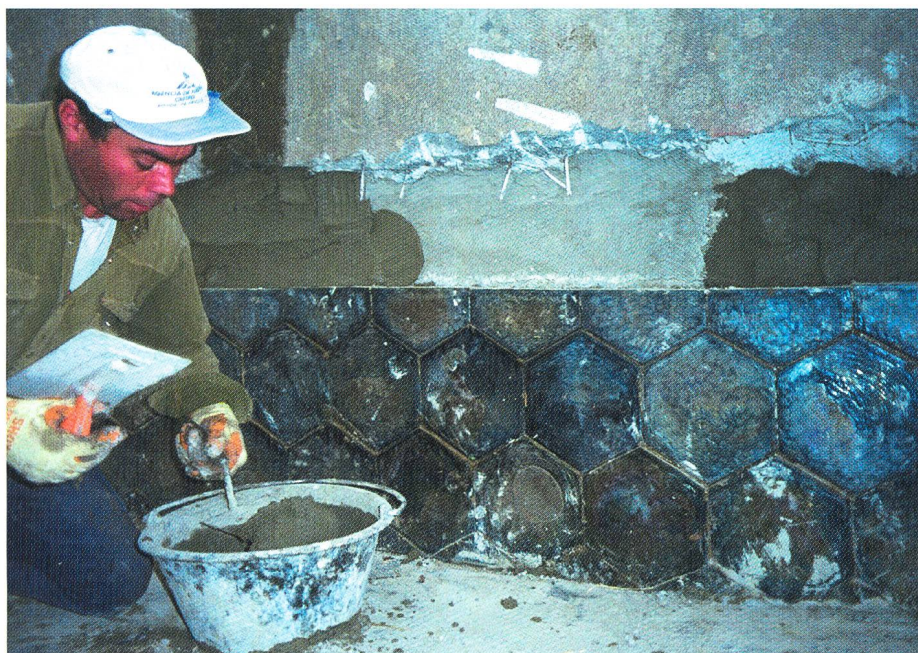
Bild 7. Der nasse Herbst und die Novemberkälte zwangen dazu, die abriebfesten Platten bei der Fassung unter einem beheizten Zelt Dach zu verlegen.
