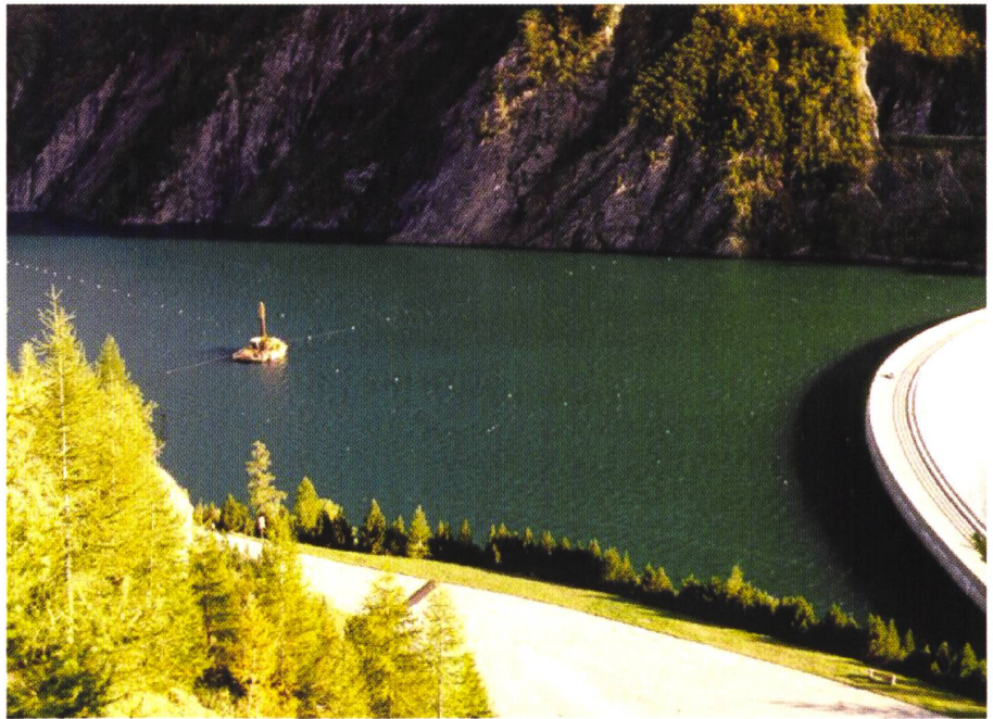
Bild 4. Bohrplattform am Standort © im Stausee Luzzone mit vier Querverankerungen.
