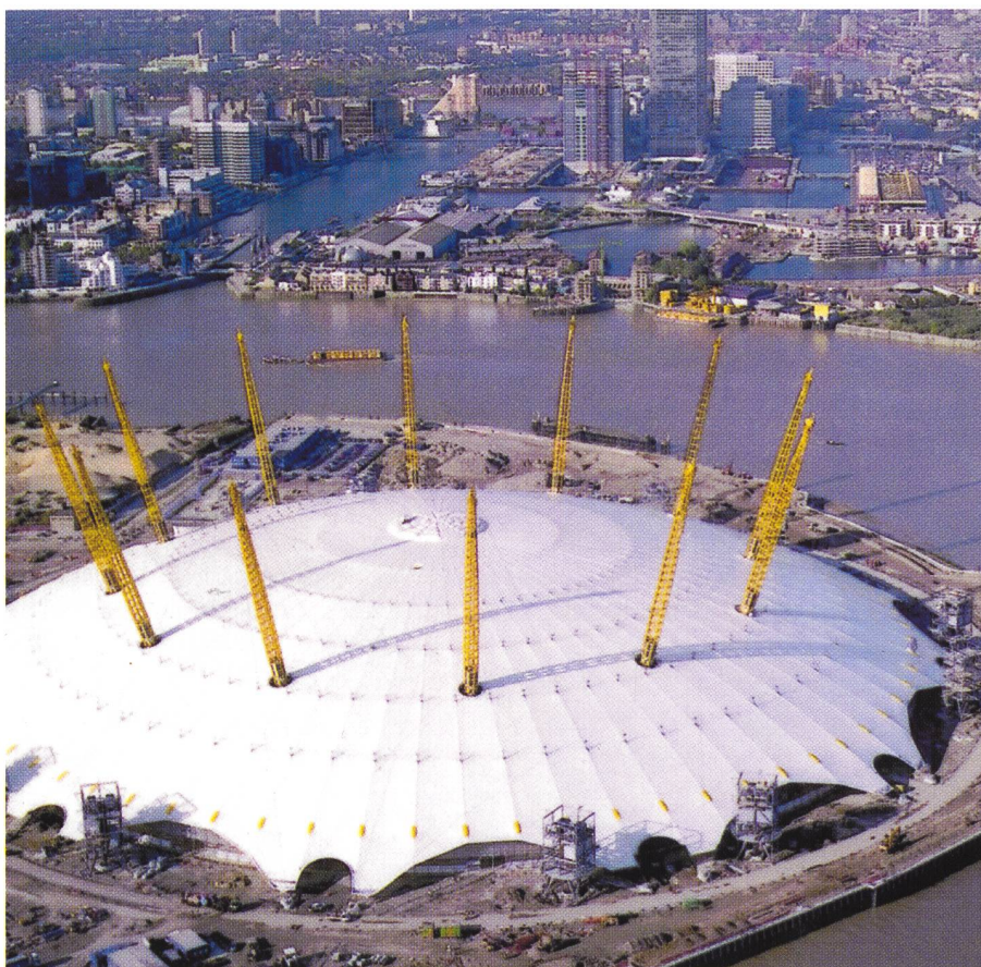
Millennium Dome, eine Ausstellungshalle zu Ehren des neuen Jahrhunderts – ein 50 m hoher Kuppelbau von 320 m Durchmesser mit zwölf 100 m hohen Stahlgittermasten für das abgespannte Dach aus kunststoffbeschichtetem Glasfasergewebe.
