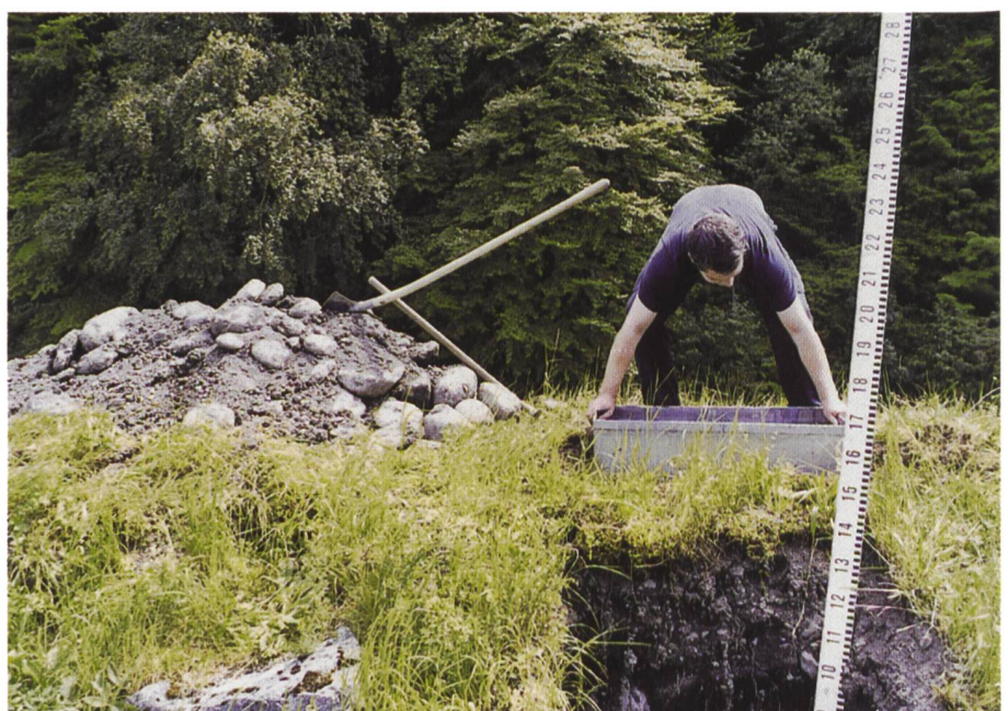
Bild 3. Baggergraben, Entnahme von Bodenproben und Versickerungsversuche an Hochwasserschutzdämmen, Lüttschne, Wilderswil, 1999.
