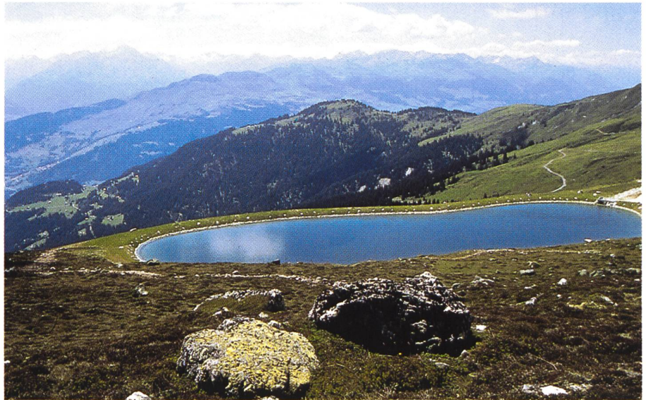
Bild 1. Das gefüllte Beschneigungsbecken auf der Alp Dado.
