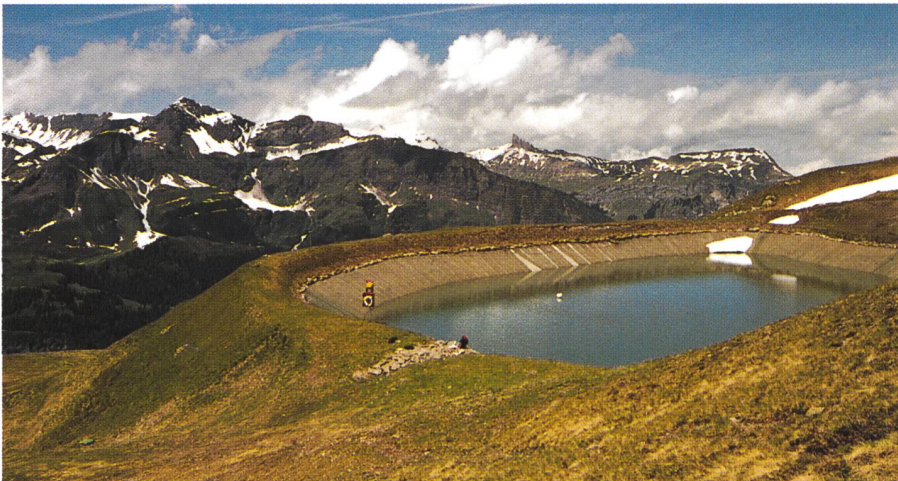
Figure 3. Bassin d'accumulation de l'aménagement pour la production de neige artificielle du Lauberhorn BE. Revêtement du talus amont avec une géomembrane (photo: A. Kobelt).
