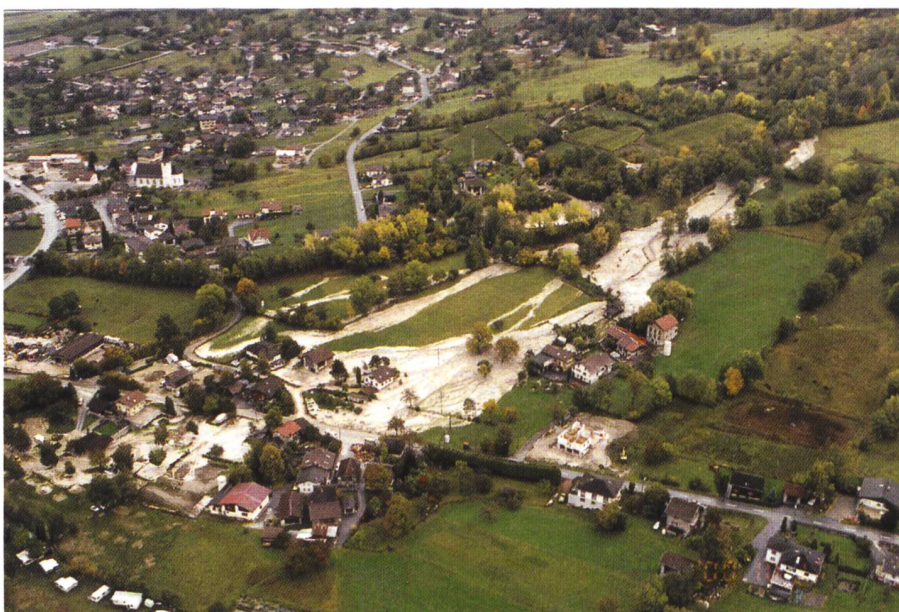
Bild 13. Meretschi: Murgang im Meretschibach. Das Gerinne auf dem Kegel wurde aufgefüllt. Einige Murschübe sind ausgebrochen und haben Teile des Dorfes Agarn verwüstet (Foto: M. Zimmermann, 17. Oktober 2000).
