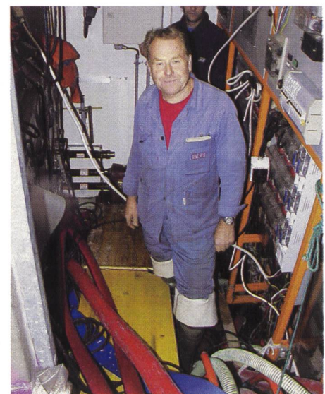
Figura 4. In sette cabine le pompe hanno funzionato giorno e notte.
