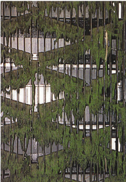
Bild 2. Grosse Rechenverluste durch Verstopfung an den Quertraversen.
