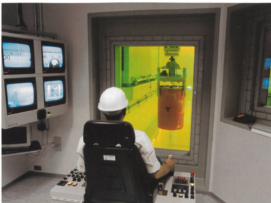
Bilder 1 und 2. Teile des heute knapp 1000 m 3 umfassenden Lagerbestandes an radioaktiven Betriebsabfällen im Kernkraftwerk Beznau. Jedes Abfallgebinde ist minutiös inventarisiert, in seiner chemischen und radiologischen Zusammensetzung erfasst und sicher untergebracht (Bild 1). Der Kranführer beschickt das Lager mittels Fernbedienung in einem geschützten Nebenraum (Bild 2).
