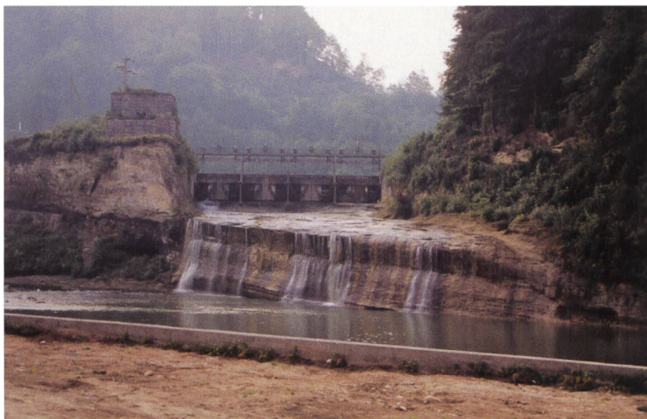
Fig. 4. Vue aval de l'évacuateur de crues actuel du barrage de la Maigrauge.
