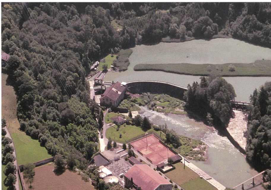
Fig. 3. Vue aérienne de l'aménagement de l'Oelberg-Maigrauge à Fribourg.
